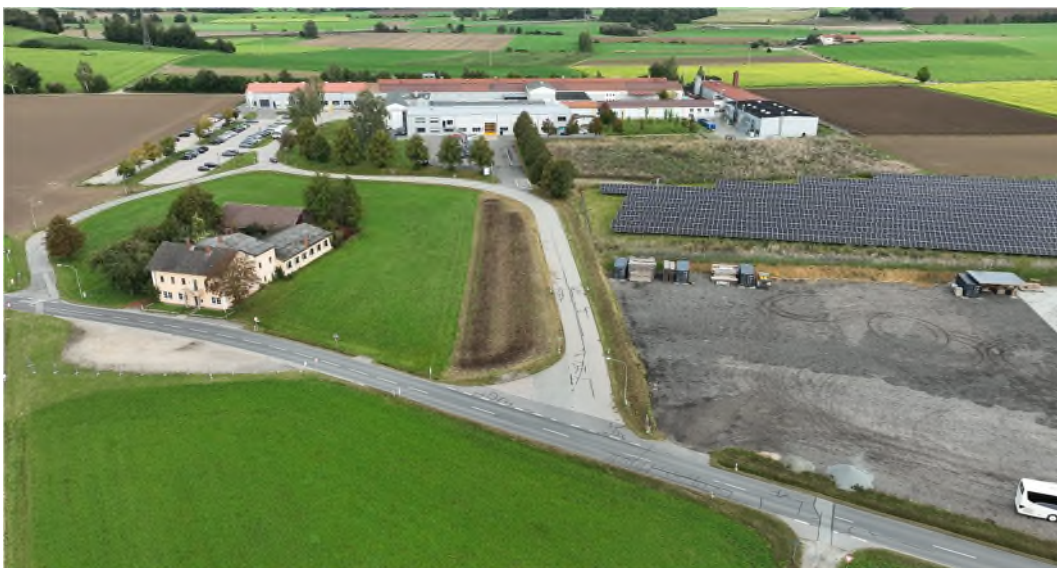
Abb. 4: geplante Erweiterung des Gewerbegebietes, Blickrichtung Norden
